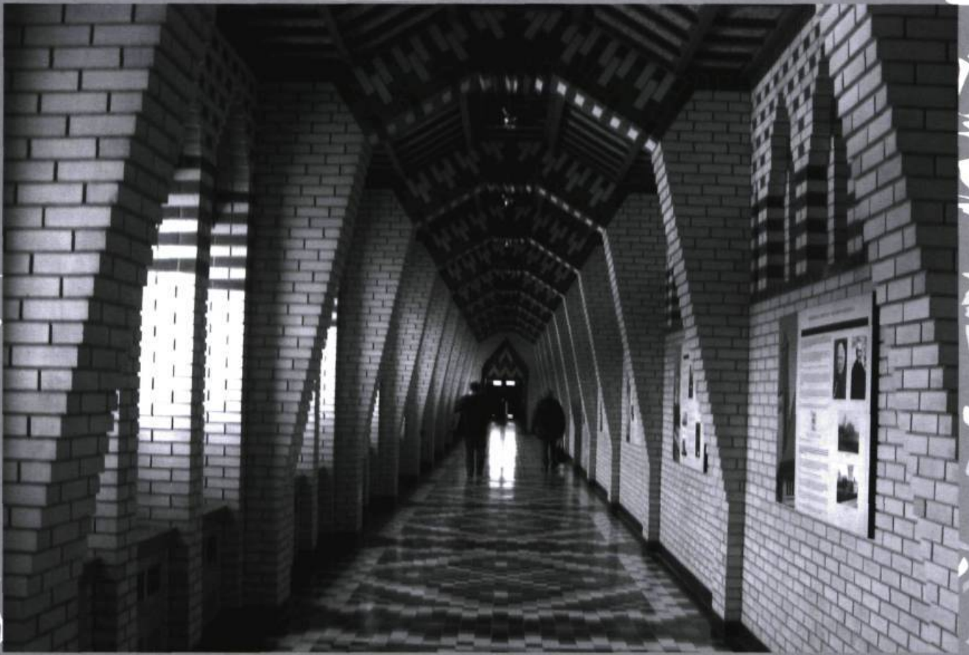
Cloître de l'hôtellerie. À droite, on voit la photo de Dom Vannier et celle de son voisin, Dom Prosper Guéranger. (Source : Maurice Langlois)
