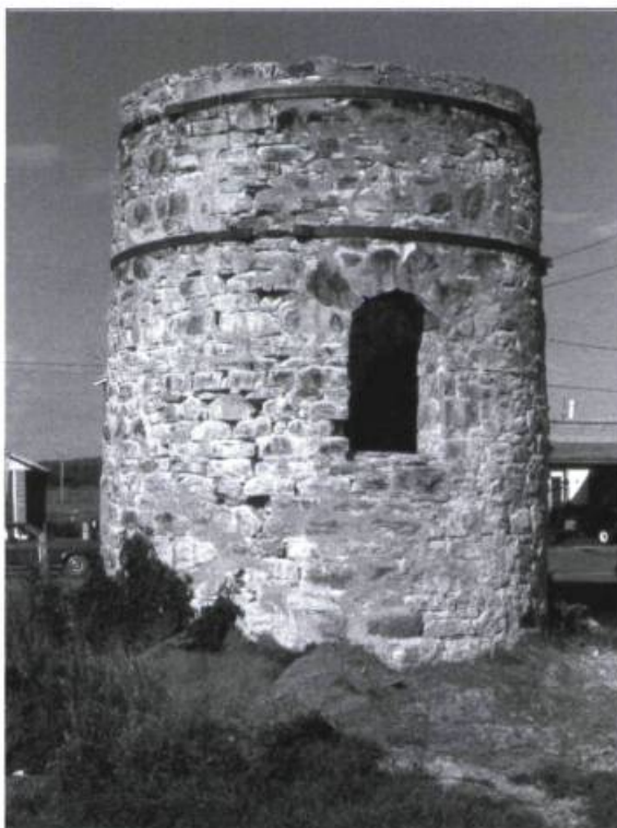
C'était le château d'eau du village.
