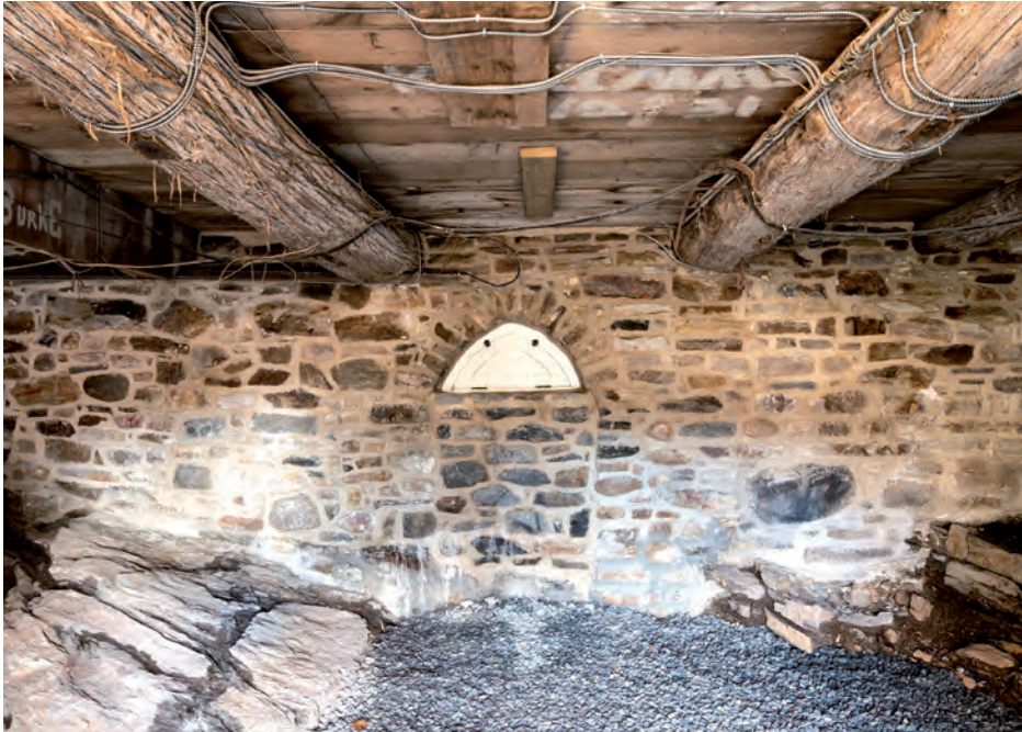
Vestige d'une ouverture qui permettait le passage de l'eau dans le soubassement du hangar à grains.
