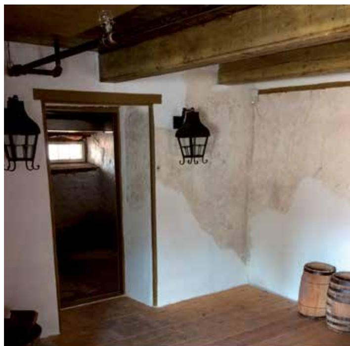
Cuisine du sous-sol avant et après les travaux. Les restaurateurs ont conservé l'enduit de chaux présent sur une partie des murs et ont recouvert le reste de la maçonnerie de pierre avec un enduit préparé selon la méthode traditionnelle, de manière à ce qu'on puisse distinguer finis ancien et récent.
