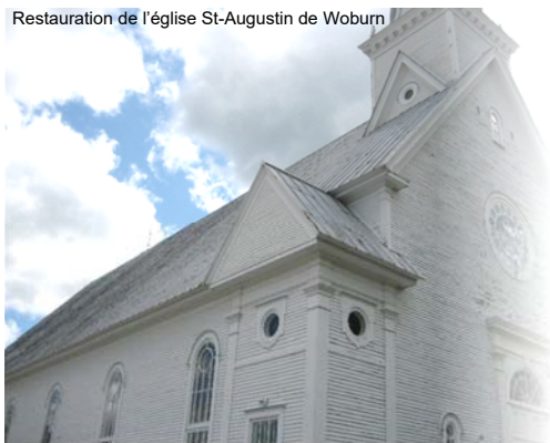
Restauration de l'église St-Augustin de Woburn
