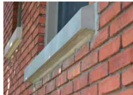
↑ Dans un bâtiment en brique, la tablette sera en pierre, débordera de l'aplomb du mur et comportera un casse-goutte le long de sa surface inférieure.
