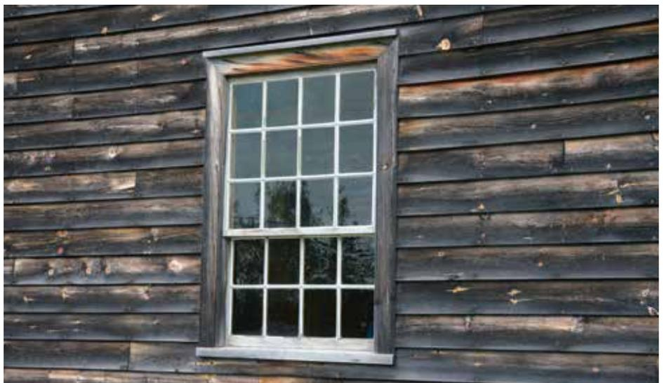
Dès le XVIII<sup>e</sup> siècle, on crée une légère pente sur le dessus du linteau (partie supérieure de l'encadrement) et de la tablette (partie inférieure) afin d'éloigner l'eau de pluie de la fenêtre.
