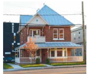
Maison Robitaille, avant et après sa restauration
