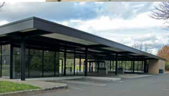
La station-service avant sa conversion
