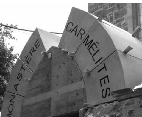
Les chaperons ont été reconstruits, parfois en béton préfabriqué ou en cuivre étamé, parfois en pierre de taille, comme ici.
