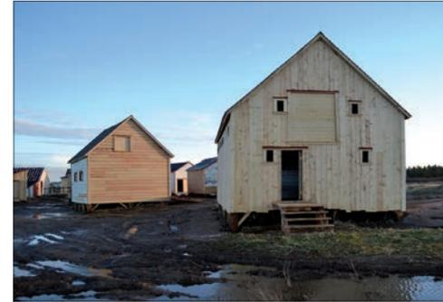
L'approche de restauration visait à réparer plutôt qu'à remplacer. Le but : conserver le plus de composantes originales possible et révéler les traces du riche passé de ce site. Même le plus petit élément d'origine en bon état a été conservé et complété par des portions neuves façonnées dans le même matériau. Les seules interventions qui ne faisaient pas partie de la construction d'origine, comme l'insertion d'un solin métallique, visaient à assurer la pérennité de l'édifice.
