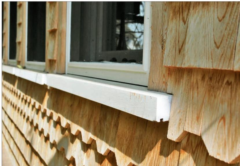
Sous la tablette des fenêtres, un casse-goutte empêche le liquide de remonter par capillarité.
