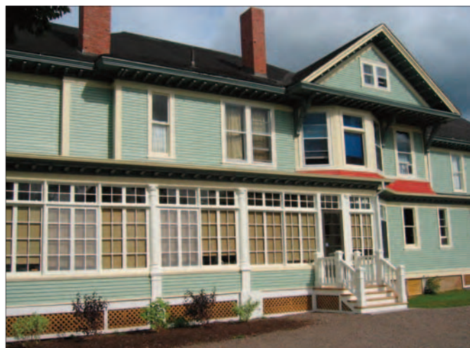
Utiliser des matériaux semblables à ceux de la construction d'origine permet d'harmoniser l'ensemble par l'unité des textures et des couleurs.
