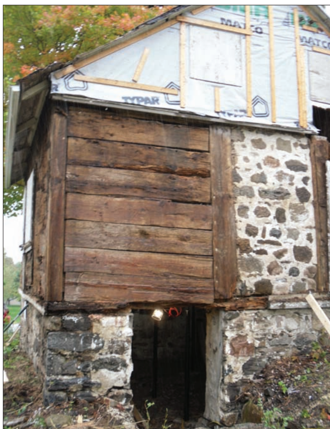
Début des travaux de restauration, en 2009. Il faut consolider la charpente du toit et d'autres éléments porteurs, rétablir l'étanchéité de la couverture et des murs extérieurs, puis rejointoyer la maçonnerie des fondations et de la cheminée.
