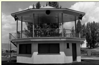
L'ancien kiosque du parc Saint-Eugène
