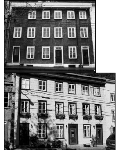
Le 340-346, rue Champlain, avant et après restauration
