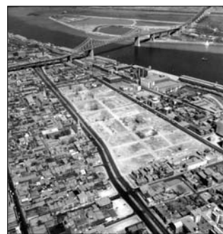
Vue aérienne du site déblayé de la future Maison de Radio-Canada, 1964
