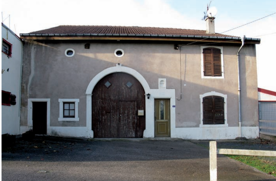
Dans cette ferme du XVIII e siècle de Sainte-Pôle, le confort naturel est assuré en été, notamment grâce aux volets et à la maçonnerie traditionnelle enduite.
