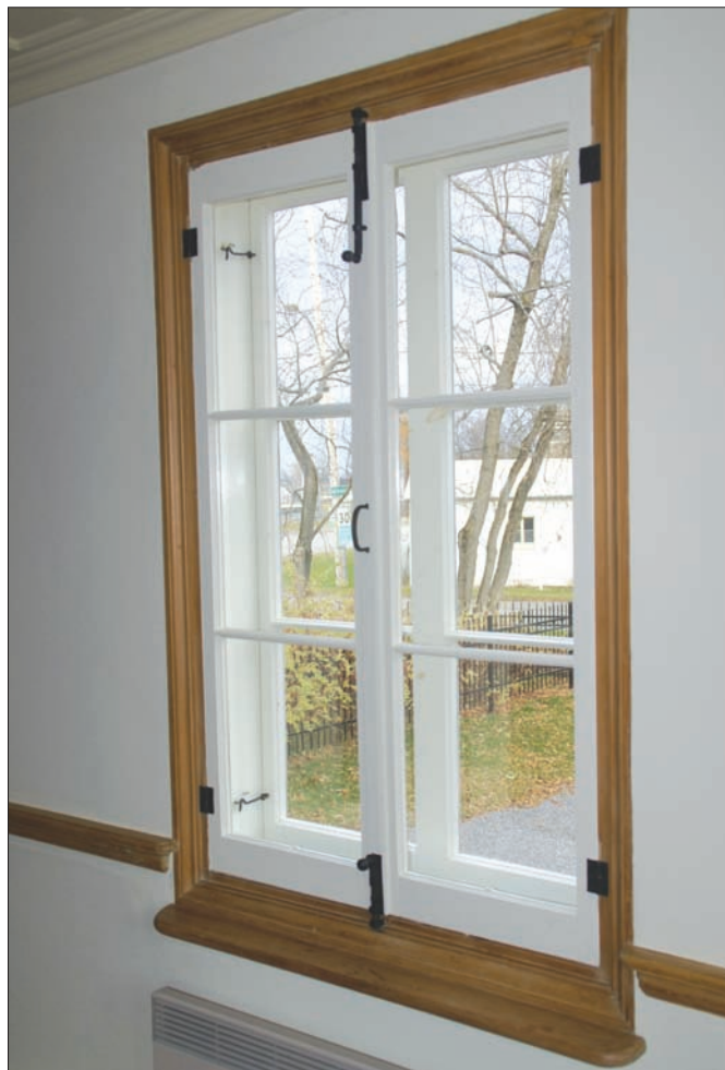
L'ensemble fenêtre et contre-fenêtre est aussi performant, énergétiquement parlant, qu'une fenêtre à verre thermos. L'espace d'air entre les vitres réduit les pertes de chaleur, sans compter que le bois est un excellent isolant.
