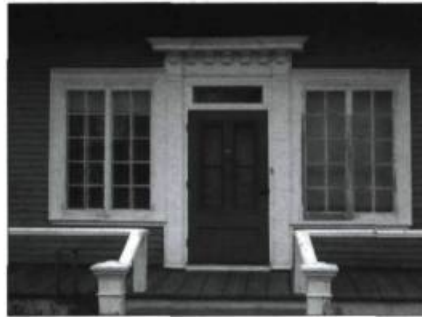
Fenêtres, contre-fenêtres et ornementation de bois doivent être conservées et entretenues pour garder le cachet de la construction.
