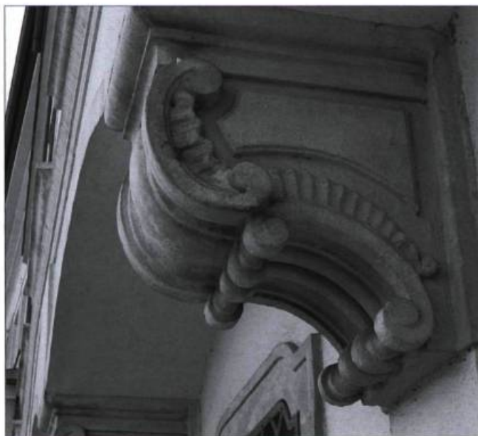
Les consoles de pierre peuvent être réparées grâce à des injections d'époxy qui viendront combler les fissures.
