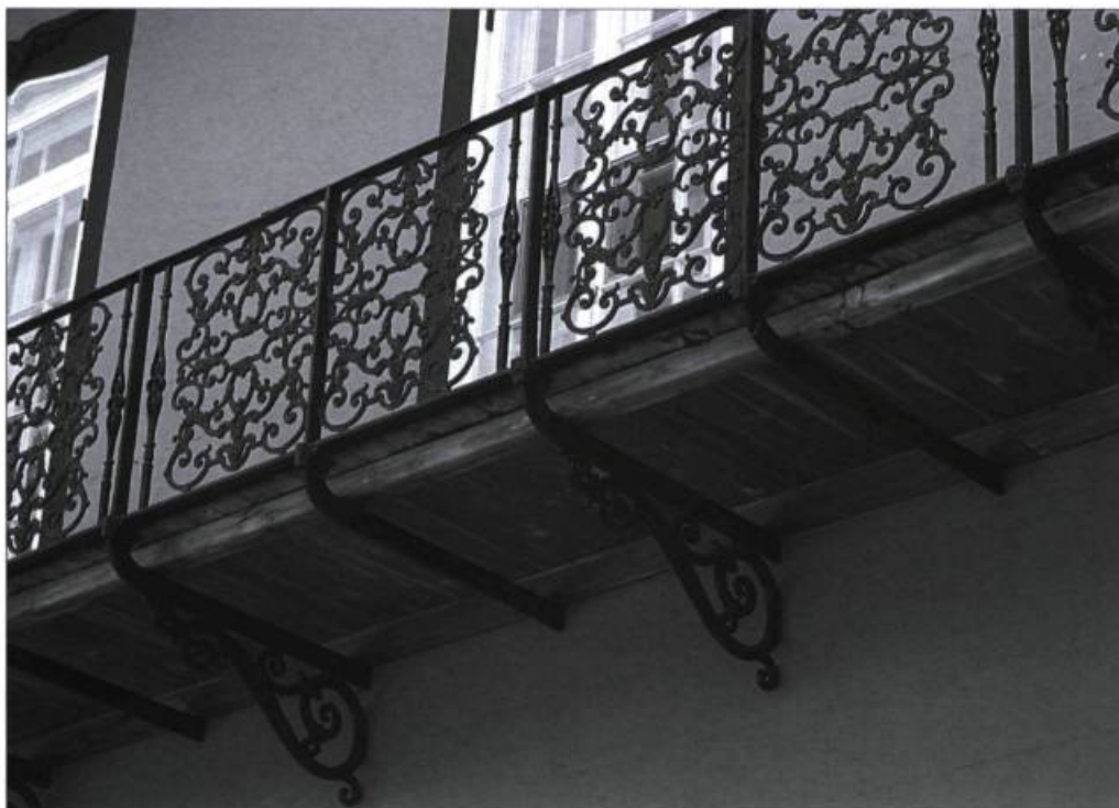
Parmi les matériaux utilisés pour les consoles, la fonte et le fer forgé créent un fort effet.
