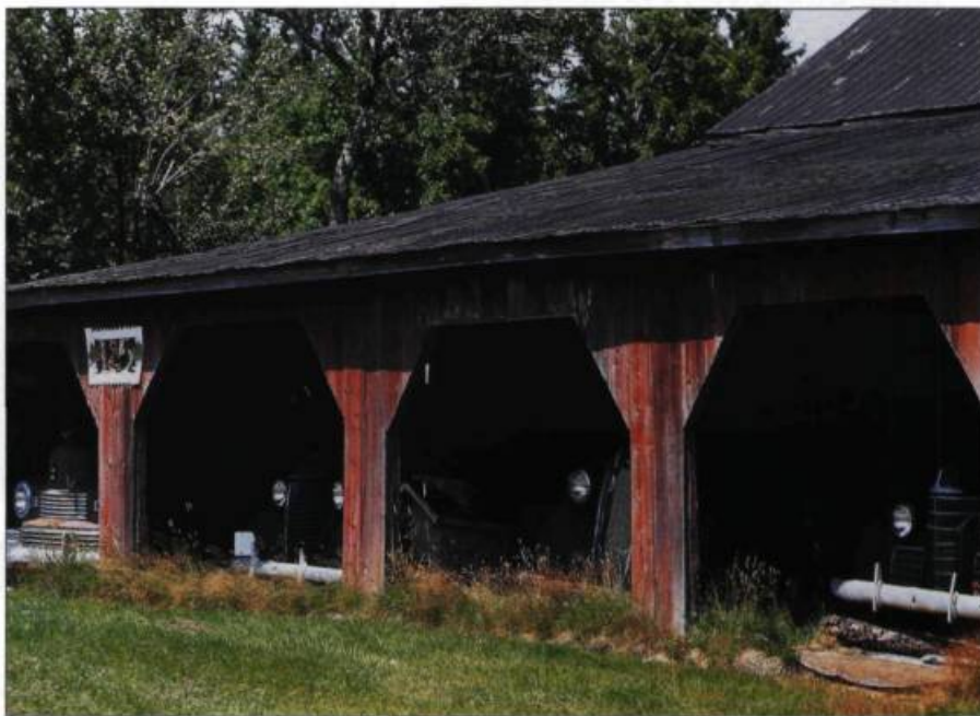
Pour éviter que les bâtiments agricoles désuets ne soient démolis, il importe de leur trouver une nouvelle vocation. Mission accomplie pour cette grange convertie en entrepôt de voitures anciennes, à Stornoway, près de Lac-Mégantic.
