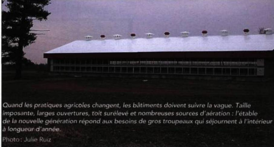
Quand les pratiques agricoles changent, les bâtiments doivent suivre la vague. Taille imposante, larges ouvertures, toit surélevé et nombreuses sources d'aération : l'étable de la nouvelle génération répond aux besoins de gros troupeaux qui séjournent à l'intérieur à longueur d'année.
