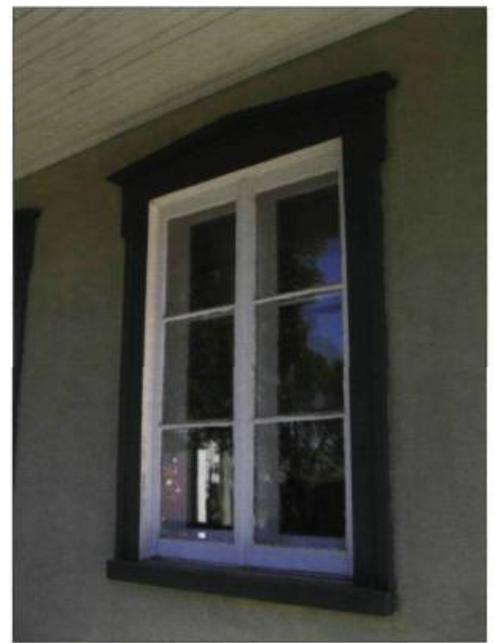
L'encadrement assure l'étanchéité de la ligne de rencontre entre la fenêtre et le mur de crépi, en protégeant ce joint de construction.
