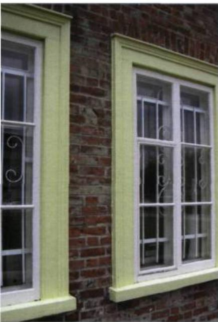
Parfois, des encadrements sont appliqués sur les murs de brique qui, d'ordinaire, n'en nécessitent pas. Cet encadrement illustre un profilé typique de la fin du XIX<sup>e</sup> siècle : une planche moulurée d'un demi-rond du côté de l'ouverture et rehaussée d'une doucine, ou gorge française.
