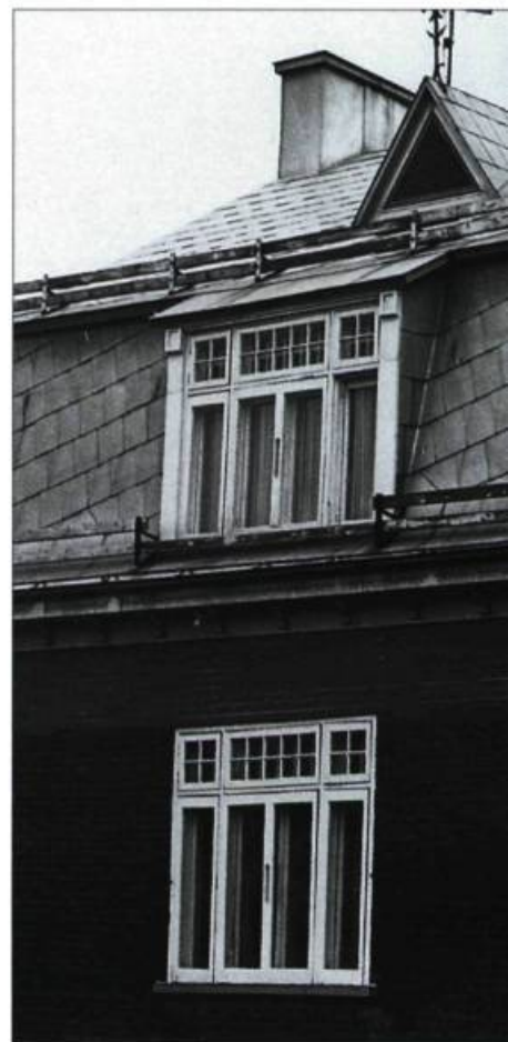
Cette lucarne rampante, dite aussi « en chien assis », est aménagée dans le versant du brisis d'une mansarde.
