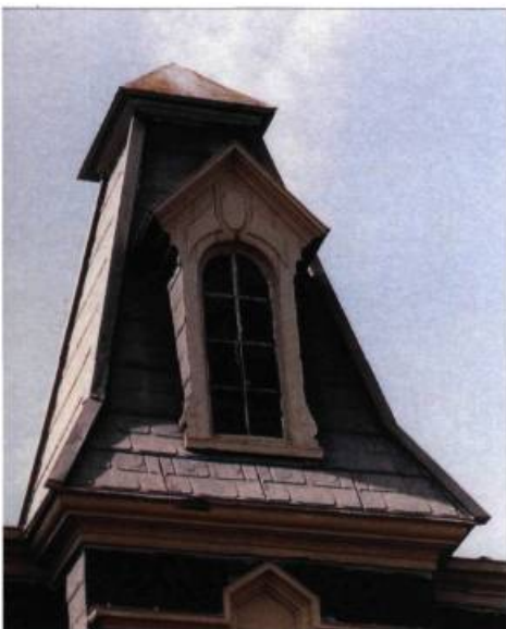
Cette lucarne à pignon avec fenêtre cintrée décore joliment l'avant-corps du bâtiment.
