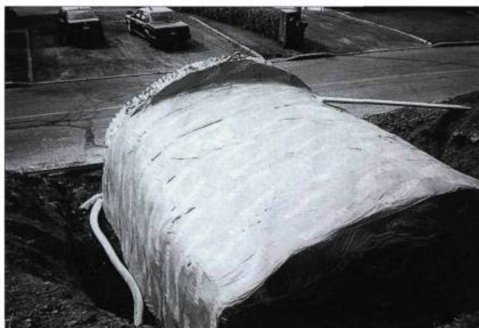
L'une des étapes de restauration du caveau consiste à le rendre étanche en installant un drain autour de la structure détériorée.
