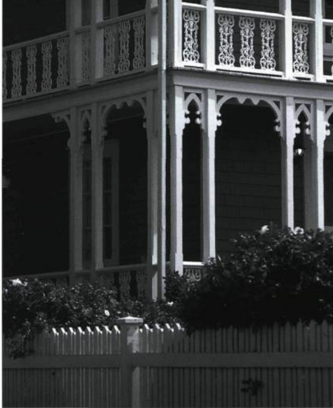
La beauté d'une maison ancienne est rehaussée par des aménagements paysagers compatibles avec son époque.
