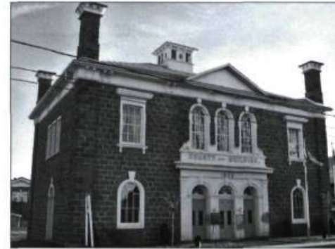
Édifice de la MRC du Haut-Saint-Laurent à Huntingdon.
