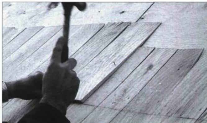
*Le pureau est la partie apparente de chaque bardeau qui sert au recouvrement d'un mur ou d'une toiture. La profondeur de ce pureau dépend du type d'élément recouvert et de l'angle s'il s'agit d'une toiture.*
