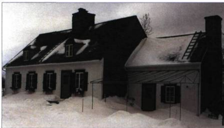
La maison de Fernande Morrissette et de Jacques Portelance est située à Berthier-sur-Mer.
