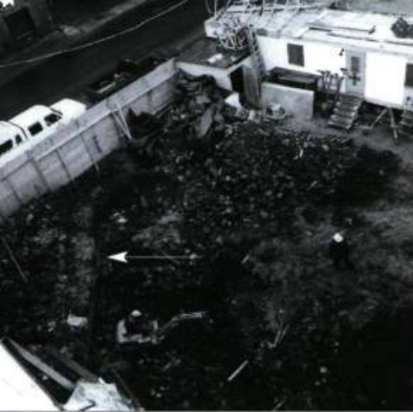
Vue des fondations du môle des quais Lyburner & Crawford. Il s'agit d'ouvrages de maçonnerie en pierre sèche composant l'armature d'un quai obstruant partiellement l'entrée du bassin situé plus à l'ouest.
