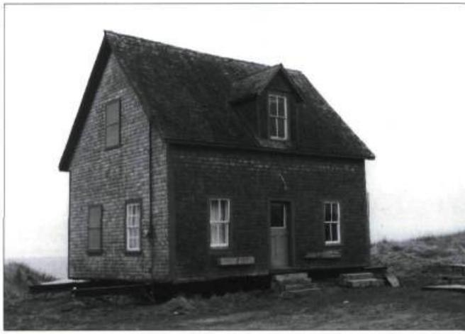
*La bâtisse à charpente de bois, reposant sur des fondations de pierres sans mortier, est levée et maintenue de niveau par deux poutres d'acier glissées transversalement.*
