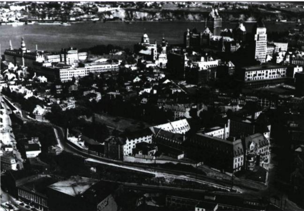
Vue aérienne du secteur de l'Hôtel-Dieu en 1938 (en bas, à droite). Le projet d'agrandissement du vénérable hôpital se concrétisera en 1952, ceci en dépit des protestations. Ce sera le dernier édifice en hauteur du quartier historique.
