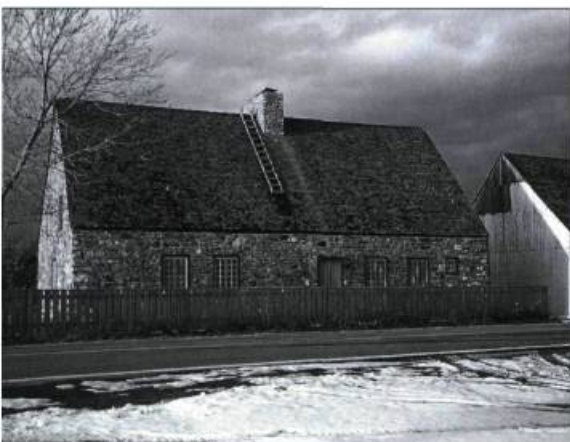
Les maisons d'« esprit français » sont encore nombreuses dans les six paroisses de l'île. Ces constructions se caractérisent, entre autres, par un toit aigu et par l'absence de rive et de larmiers.
