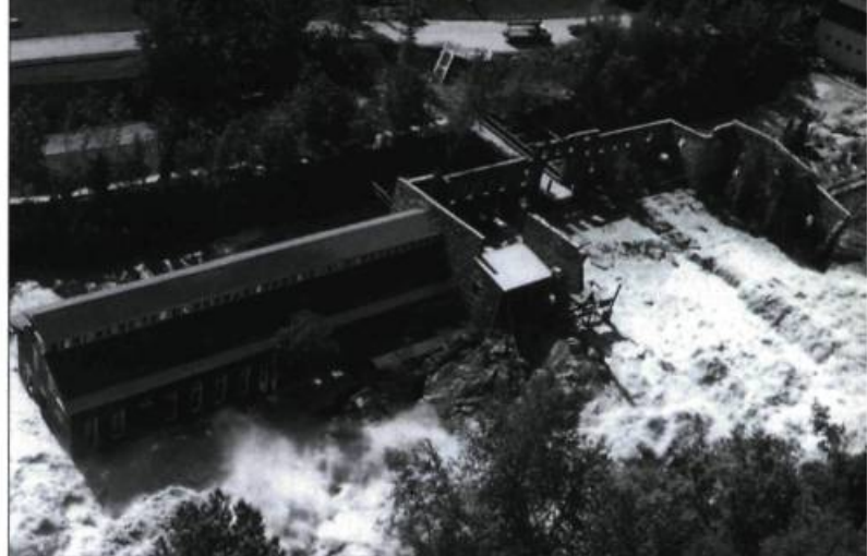
Vue rapprochée des moulins du site historique de la Pulperie, jour 6 de l'inondation.
