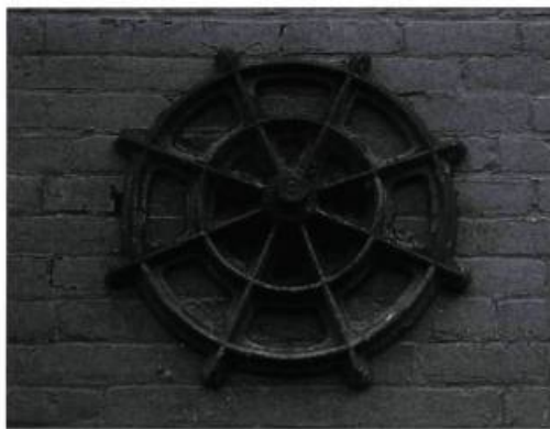
Ancre en fonte imitant une roue de bateau sur la raffinerie de 1871 du complexe de John Redpath.
