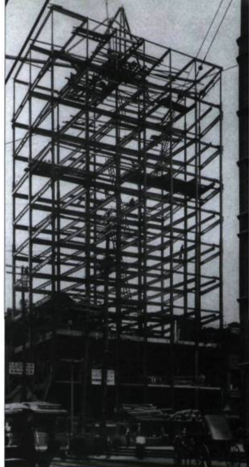
En 1912, le montage de la structure d'acier de l'immeuble Duluth, près de l'église Notre-Dame, va bon train.
