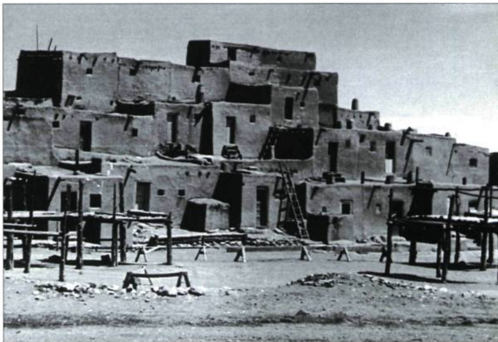
Les Indiens Pueblos ne coupent jamais les poutres de cèdre qui traversent les murs d'adobe (terre cuite au soleil) de leurs unités de logement à niveaux multiples.
