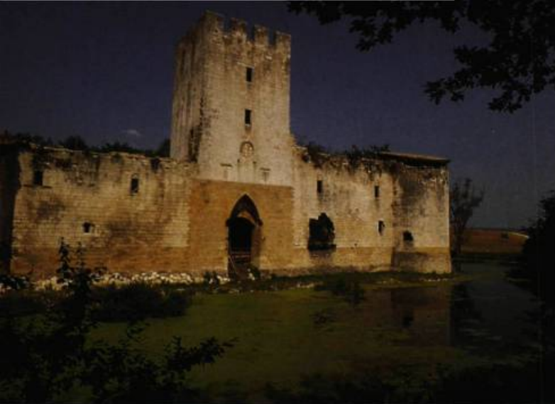
Le château de Gombervaux entouré de ses douves. On remarque l'utilisation systématique de la pierre brune dans les parties basses du château. Photo : Denis Couillard De Lespinay
