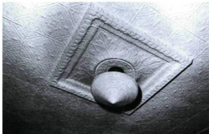
Plafond décoré d'un revêtement de feuilles de tôle pressée avec une tôle particulière pour inscrire le luminaire au centre de la pièce.
