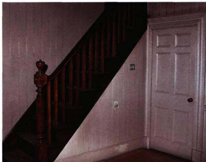
Un décor intérieur caractéristique de la fin des années 1880: un revêtement de planches embouvetées avec une rainure en «V» est complété d'une plinthe et d'une corniche. Une cimaise à hauteur d'appui donne une touche élégante.
