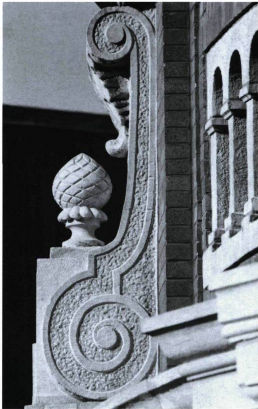
Détail de la corniche. Photo: Jean-Marie Villeneuve.
