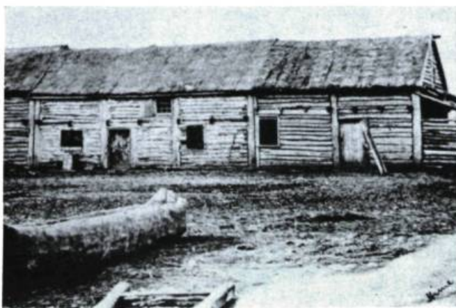
Une photographie ancienne illustrant le type de construction «poteaux à coulisse». Tirée de John I. Rempel.
