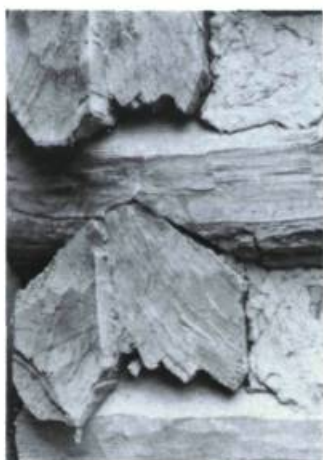
Détail d'assemblage illustrant la taille en A des extrémités des pièces pour bien chaîner les coins du bâtiment. Tirée de John I. Rempel.
