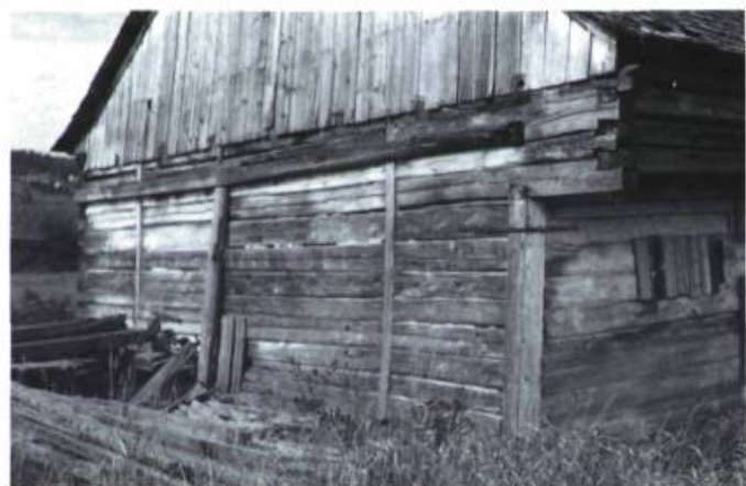
Belle grange de la région de Charlevoix en pièce sur pièce avec encorbellement et assemblage à queue d'aronde. Photo: François Varin.
