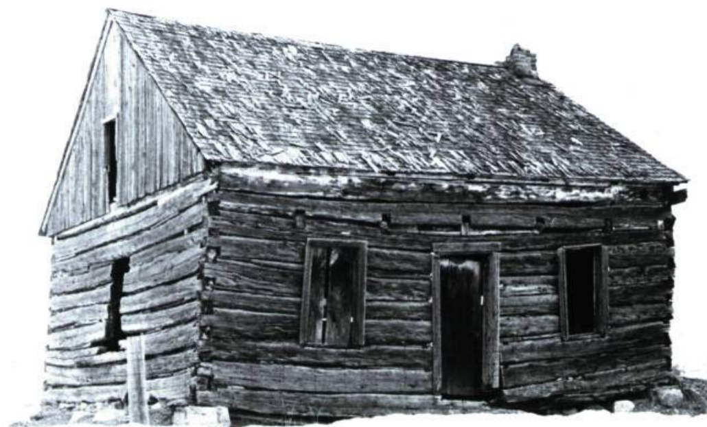
Ancienne demeure dans la région de Montréal composée de pièces de bois assemblées à queue d'aronde, qui laisse voir l'extrémité des solives du plancher de l'étage. Photo: François Varin.
