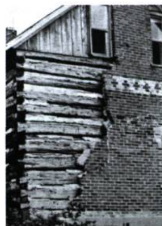
Sous un revêtement contemporain ou postérieur se révèle le carré ancien de la maison en pièce sur pièce. Tirée de John I. Rempel, Building with Wood , University of Toronto Press, 1980, 454 p.
