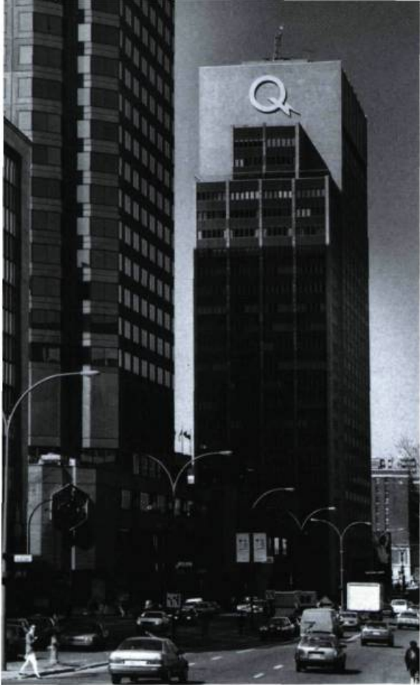
L'immeuble d'Hydro-Québec reprend de manière épurée les éléments du gratte-ciel classique. Photo: Alain Lesieur.
