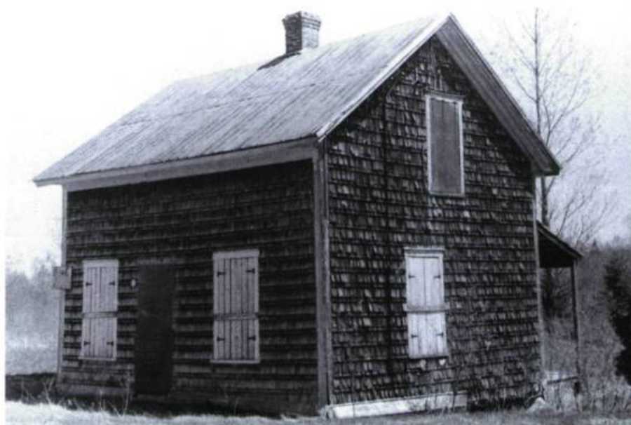
2. Bel exemple d'une maison de colonisation, malheureusement abandonnée. On remarque les éléments d'origine: bardeaux sur les murs, encadrements et planches cornières, larmier et rives des pignons qui excèdent d'environ 14 pouces, cheminée de briques en encorbellement au centre du toit, ouvertures distribuées selon les normes de l'époque. La tôle a cependant remplacé le bardeau d'origine sur la toiture. (photo: François Varin)
