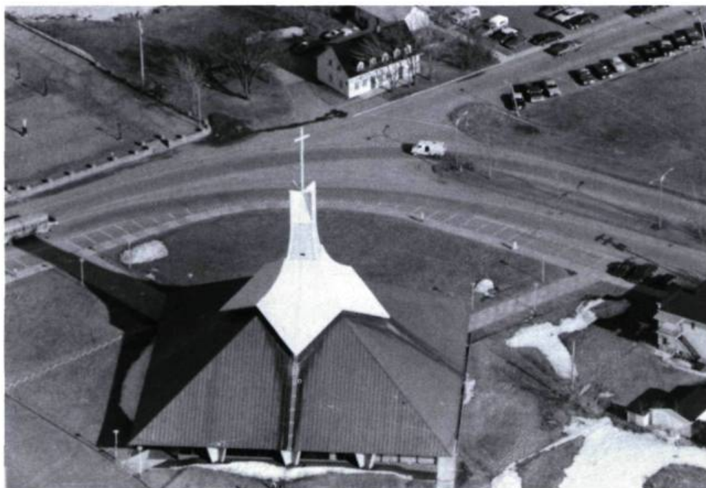
Parmi les nombreuses églises qui exploitent le thème de la tente, Notre-Dame de Roberval est particulièrement convaincante. Œuvre de l'architecte Fernand Tremblay, de l'agence St-Gelais, Tremblay, Tremblay, ce monument de la modernité est formé d'une structure de puissants chevrons en béton qui dégagent une nef s'enfonçant dans le sol. (photo: M.A.C., R.-P. Monnier)
