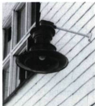
Appareil d'éclairage que l'on trouvait fréquemment sur les bâtiments industriels, les entrepôts ou les ateliers. Ce modèle date du début du siècle et orne la façade de l'entrepôt de la compagnie Robin, à Bonaventure. L'édifice recyclé l'a conservé. (photo: François Varin)
