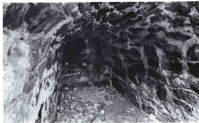
Vue de l'embrasure de la soufflerie du haut fourneau Grondin en 1976. (photo: Service canadien des parcs, Jean Bélisle)
