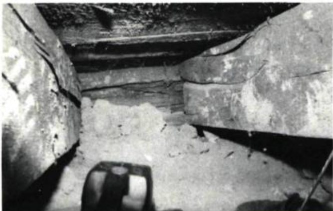
Dans le vide sanitaire, les éléments de la structure ne doivent pas être en contact avec la terre.
