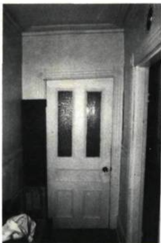
Des pentes dans les cadrages sont un signe de l'affaissement des murs porteurs.
