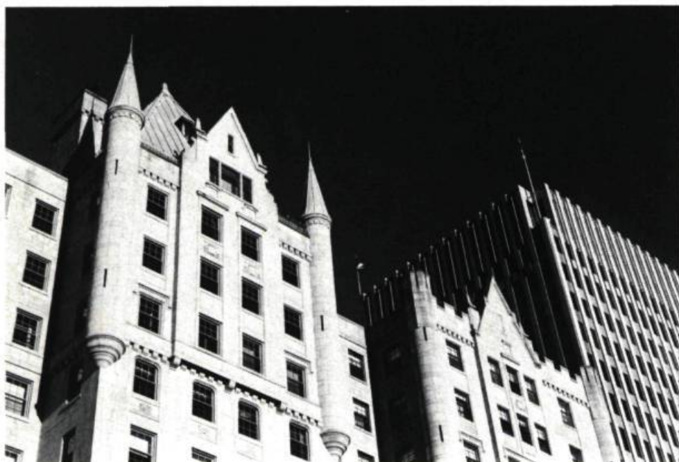
Érigé en 1925, le Château est l'un des immeubles résidentiels les plus remarquables à Montréal. (photo: B. Ostiguy)
