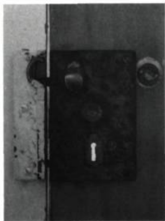
6. Serrure en fonte (fin du XIX e siècle) fabriquée en Ontario par la compagnie Peterboro. C'est le modèle du genre le plus répandu au Québec. Avec son boîtier noir et son bouton de porcelaine blanche, il accentue la beauté des portes de 1885 à 1920. (photo: D. Dion)
