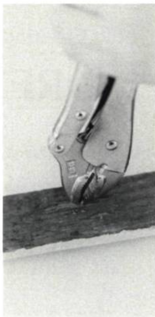
8. Les clous se retirent par l'arrière de la moulure, en utilisant une pince comme levier. (photo: F. Varin)
