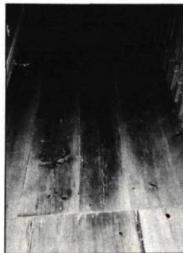
11. Exemple de plancher sablé et «varathané» qui laisse voir l'usure du temps et les traces de l'occupation du bâtiment. (photo: F. Varin)
