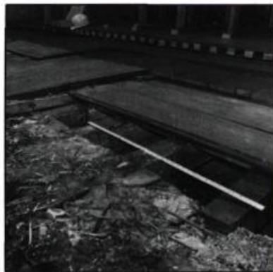
6. Photo prise à la suite d'un curetage où l'on distingue les quatre rangs de planches successifs, le plancher original étant constitué d'épaisses planches emboutées clouées aux solives. (photo: Parcs Canada)
